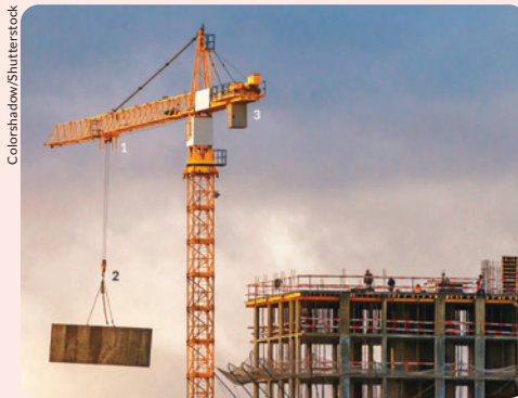
IMAGEM 33: grua levando materiais para o alto de um prédio em construção.
