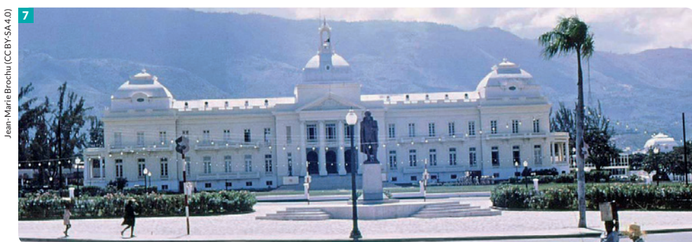
IMAGEM 8: Palácio Nacional do Haiti, severamente danificado depois do terremoto de 2010.
