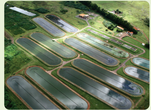
IMAGEM 8: estação de tratamento de esgoto, rio Alagado, Itaperuna, RJ.
