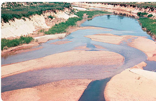
IMAGEM 16: rio sem mata ciliar, em estado avançado de assoreamento.
