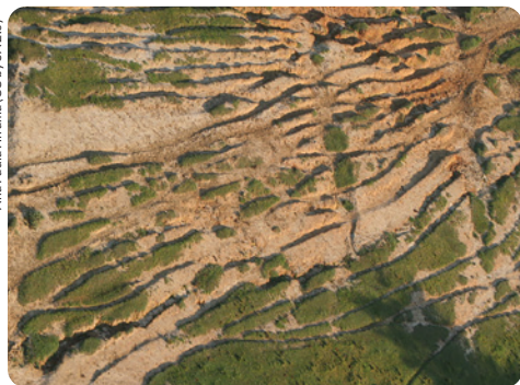
IMAGEM 15: solo em estado avançado de erosão, Piracicaba, SP.
