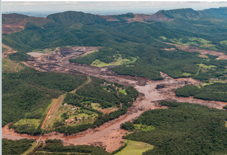
IMAGEM 11: ponte destruída pela força da lama que rompeu a barragem de mineração em Brumadinho.
