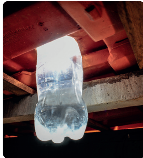
IMAGEM 20: garrafa de Moser iluminando um ambiente e economizando energia elétrica.
